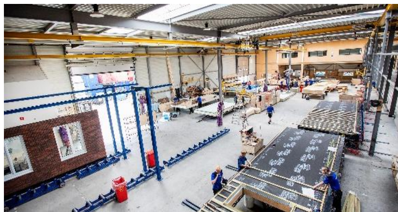
Gerobotiseerde gevel- & HSB fabriek
